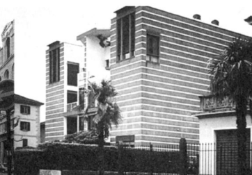
Aurelio Galfetti, Villa in Via Mirasole, Bellinzona, 1985
